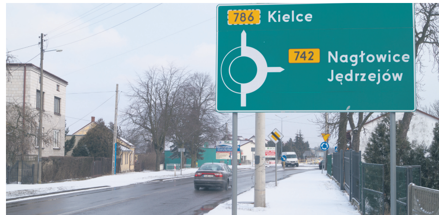
Jednym z elementów inwestycji jest modernizacja liczącego ponad dwa kilometry odcinka ulicy Jędrzejowskiej
